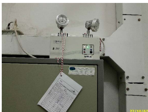
โคมไฟฟ้าแสงสว่างฉุกเฉิน
